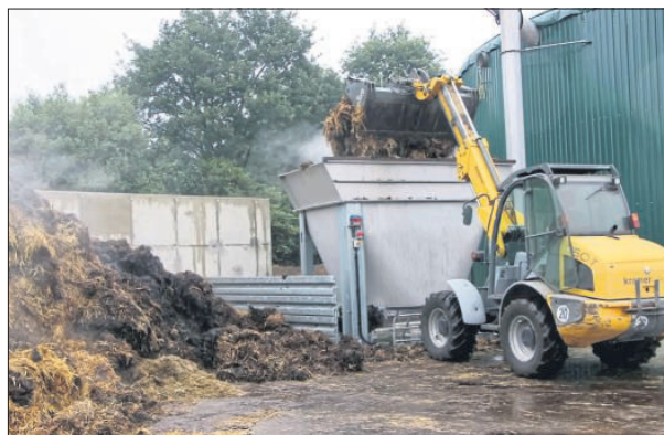
Der Dosierbehälter für den Festmist wird täglich mit einem Radlader beschickt. Von dort wird er per Förderschnecke automatisch in den Fermenter transportiert. Foto: Benker
