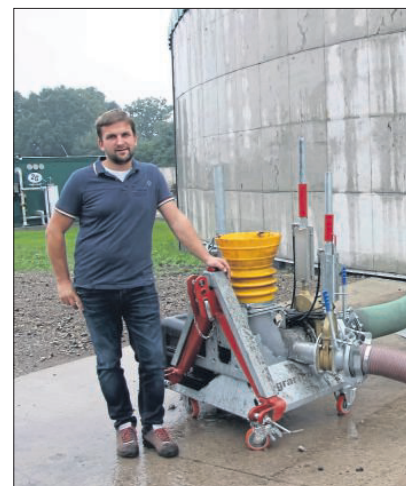
An dieser Zapfstelle kann Thomas Kamphake problemlos die Gärreste mit dem Güllefass entnehmen. Foto: Benker
