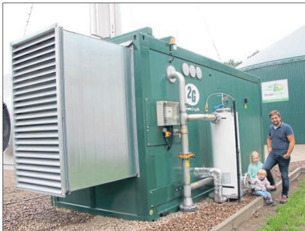
Thomas Kamphake mit seinen Töchtern Ella und Luisa am Herzstück seiner Biogasanlage auf dem Hof in Ströhen, dem 75 kW-Hofkraftwerk.
