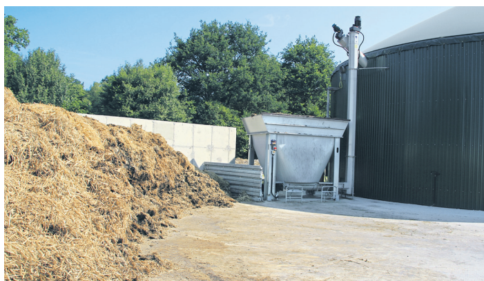
Auf dem Betrieb Kastens wird neben Rindergülle auch ein Großteil des Rindermistes in der 75 kW-Anlage verstromt.
