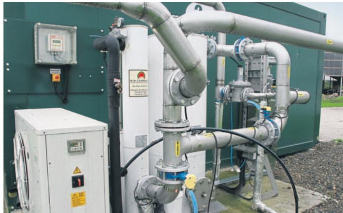
Der Aktivkohlefilter senkt den Schwefelgehalt im Biogas von 150 ppm (Fermenter) und 30 ppm (Gärrestlager) auf 0 ppm.
